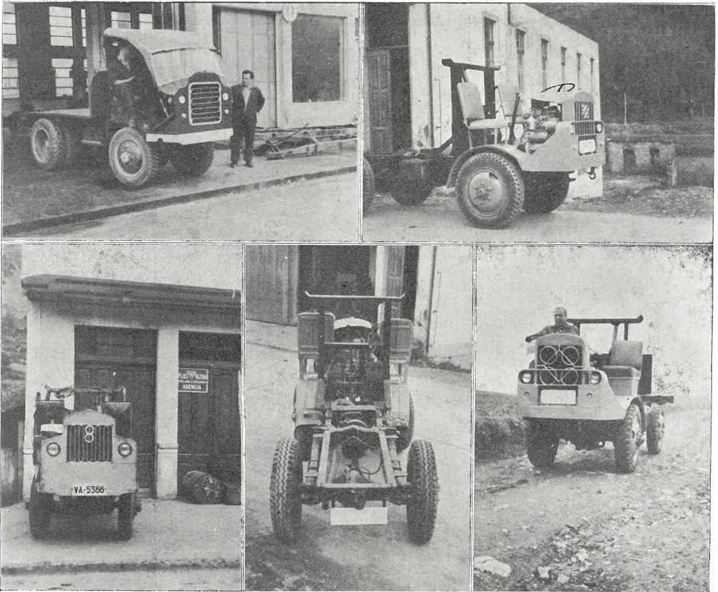
Tipos de carroquetas de los talleres de Puente Nuevo. Foto 1.—Modelo construido en los de D. Dositeo González Trigo. Fotos 2, 4 y 5.—Modelos de los «Talleres Miranda». Foto 3.—Modelo que fabrica D. Manuel Quiñoá Lombardía, o «Talleres Lobo». Por el símbolo que figura en el radiador se conoce la marca del motor utilizado en el vehículo
